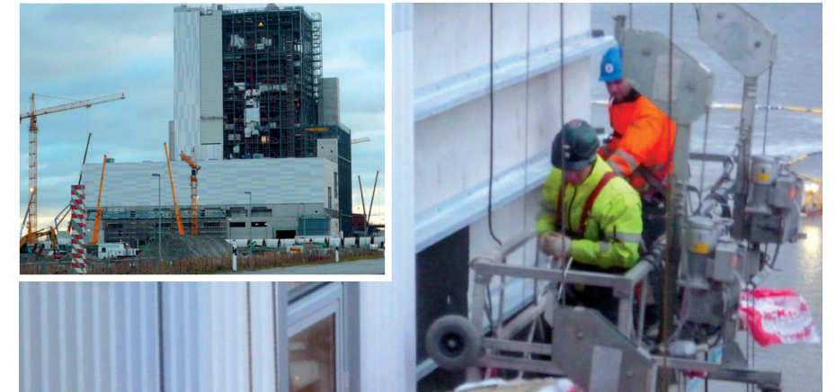
Montage der Dämmung in die Kantkassetten. Obenlinks: Baustelle im Januar 2011
